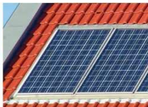
Impianto totalmente integrato
